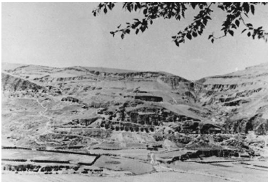
位于安塞县黄瓜塌的陕甘宁边区医院旧址全景
